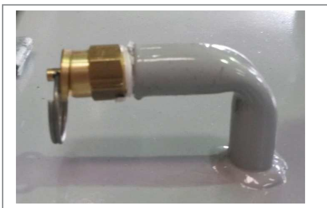
FIGURA 16: Válvula de alívio de pressão
