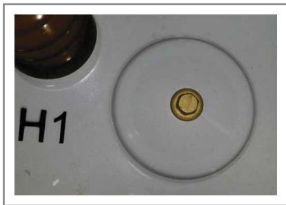
FIGURA 13: Tampa de inspeção
