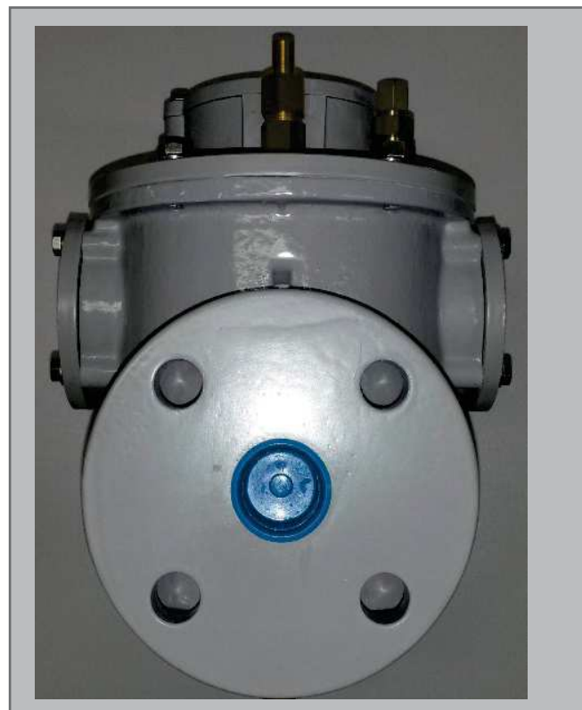
FIGURA 24: Vista lateral relé de gás
